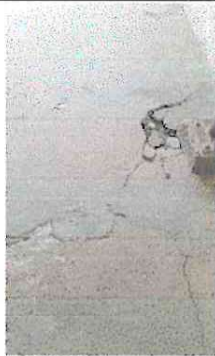
Foto 3: Sustitución de piso de aulas y corredor
