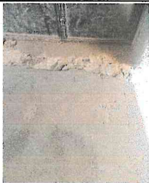
Foto1: Sustitución de piso con concreto
