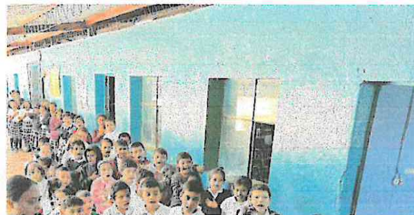
Foto 2: Sustitución de estructura de metal de ventanas
